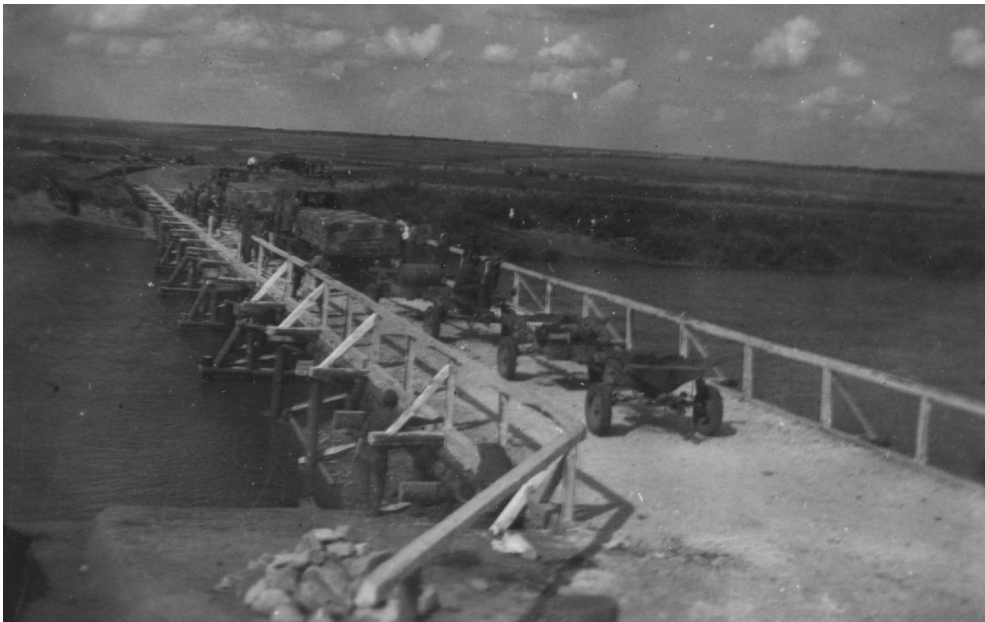
51. A 152. utászsorozat által készített szükség híd
